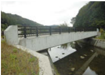
一級河川与布土川 木戸岩橋 老朽化に伴うPCポストテンション 単純床版橋の架替え(L=22.9m)
