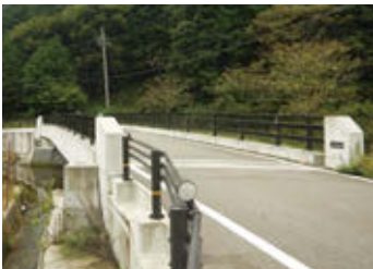
一級河川与布土川 木戸岩橋 老朽化に伴うPCポストテンション 単純床版橋の架替え(L=22.9m)
