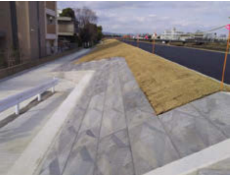
粘り強い堤防【猪名川】 粘り強い堤防構造として裏法尻を補強
