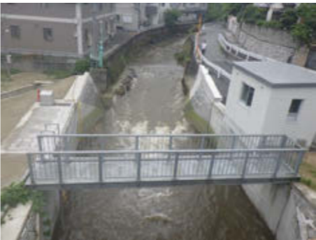
中山井堰【秋篠川】 鋼製起伏堰
