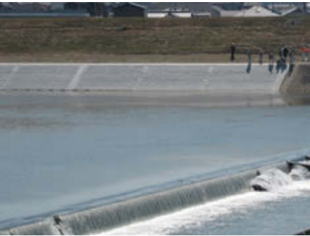
魚巢ブロック護岸【大和川】 魚類等の栄巢を提供する護岸
