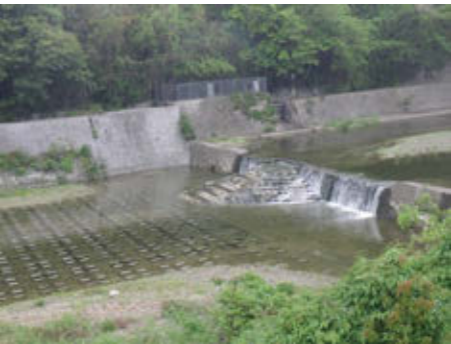
護床工および魚道【榎尾川】 河床洗堀防止のための護床工 魚類の遡上を考慮した小わざ魚道
