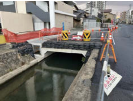
函渠工【妓王井川】 河川・道路の一体的整備を目指した ボックスカルバート
