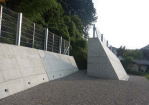
北中Ⅰ地区 待受け擁壁 重力式待受け擁壁
