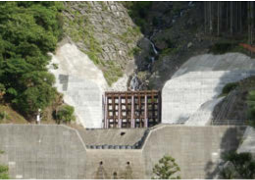
鍛冶屋谷 砂防堰堤 透過型砂防堰堤(H=10.0m)
