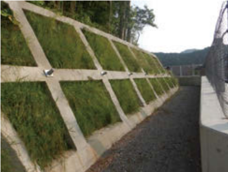
北中Ⅰ地区 法面工 吹付法枠工＋鉄筋挿入工
