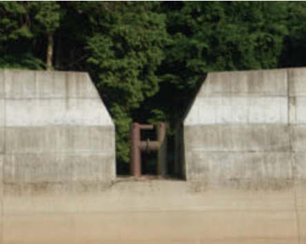
山下川 砂防堰堤 既設堰堤を改良し、流木捕捉工を設置
