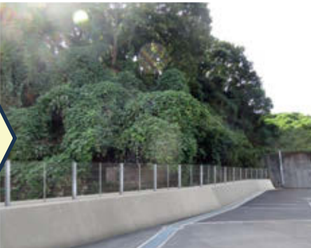
山下川 砂防堰堤 既設堰堤を改良し、流木捕捉工を設置
