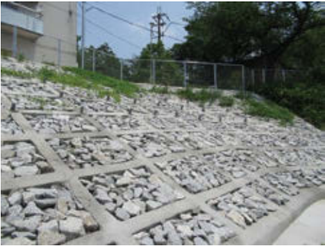
槇塚台 法面工 場所打ち法枠
