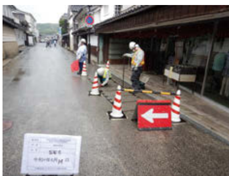
阿知42号線外 電線共同溝柵調査状況
