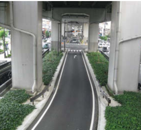
国道43号 高架下右折レーンの増設による渋滞対策
