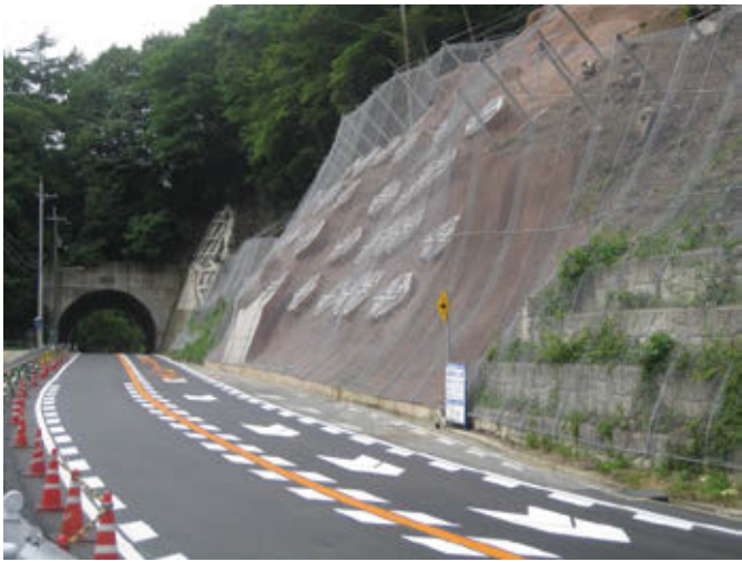
国道168号 ポケット式落石防護網工とグラウンドアンカー工 による道路防災対策
